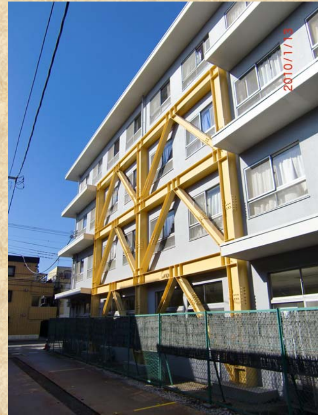
耐震補強工事部分
