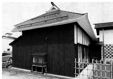
室外機 1 (建物西側)
