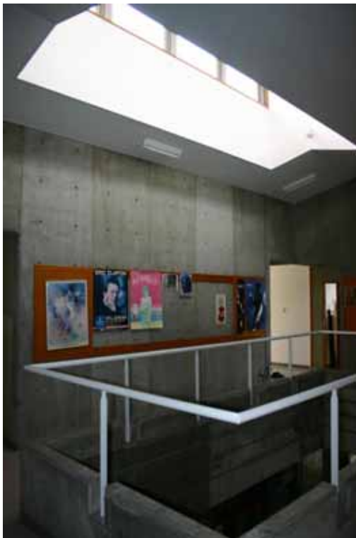
西側正面外観屋根、外装改修。玄関前舗装。 中央ホール吹き抜け二階
