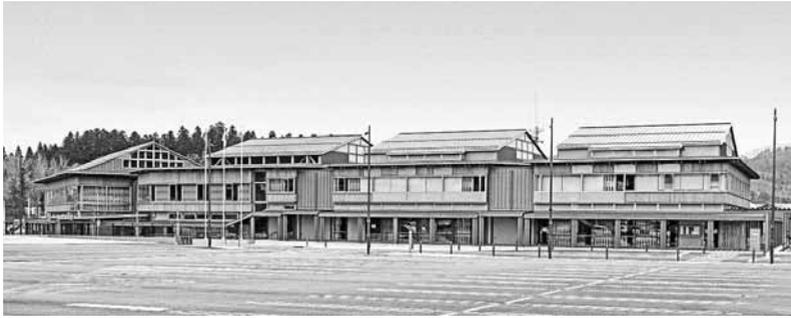
七十五％（一、二七七㎡）が町産スギ材です。町産材は冬季間の降雪による根曲がりのため、調達可能な寸法が限られています。しかしながら、長年、豪雪地帯の厳しい環境に耐えてきたためか、強度・剛性には全く問題ないどころか優位性があることが確認されています。この町産材を最大限有効活用するため、調達可能な材の寸法から逆算し、大部分に平角材の合わせ梁を取入れるという工夫を凝らしています。
