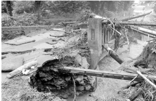
織機川の渦流で崩壊した四谷橋
