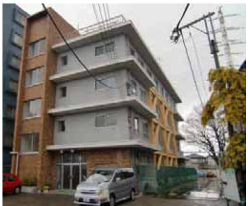
註：1〜3階南外壁(右手)に耐震補強鉄骨ブレースがつき、左の階段室が防火区画されました
